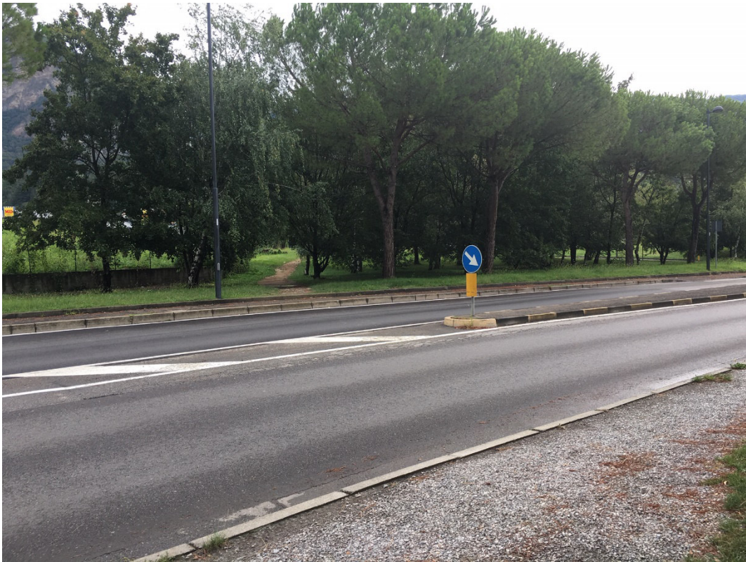
Foto n. 15 – Zona di attraversamento su via De Gasperi
