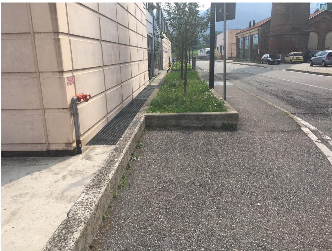
Foto n. 2 Percorso pedonale esistente
