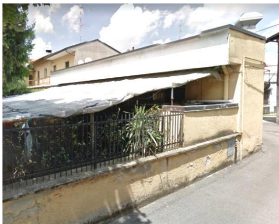
Sedimentazione di interventi che alterano e contrastano con il quadro visivo del Centro Storico.
