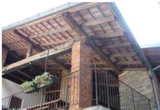
Sottogronda (e struttura) lignea senza assito
