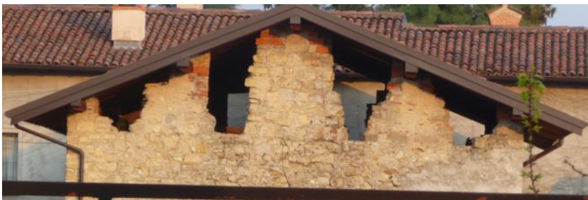
Negli edifici rustici, laddove presente, l'intonaco è spesso realizzato con la tecnica del "rasapietra"
