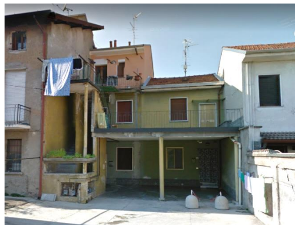
Edificio ove l'andamento della copertura e le discontinuità dei fronti edilizi determinano un quadro visivo in contrasto con il Centro Storico.
