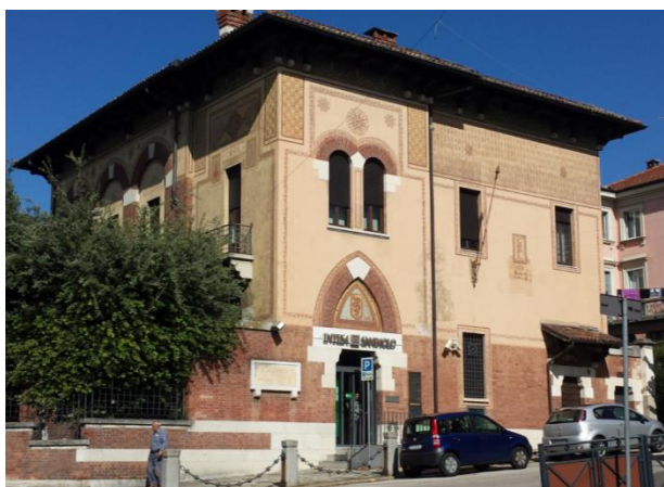
Edificio di inizio metà del '900 comunque da salvaguardare
