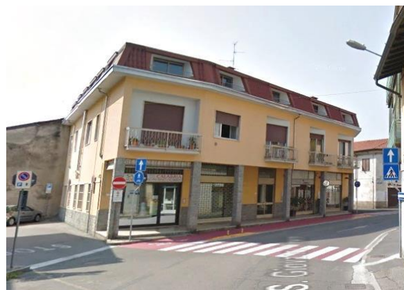
Ristrutturazione edilizia recente ove l'andamento della copertura, le aperture di facciata e gli oscuranti definiscono, nel complesso, un quadro visivo in contrasto con il Centro Storico.
