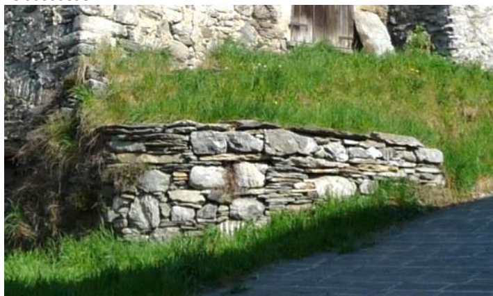
Muro a secco originario, con funzione di contenimento e delimitazione di
