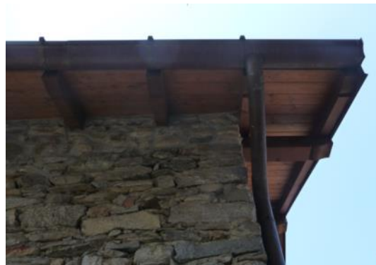
Sottogronda con struttura lignea e assito. Latterie in rame.
