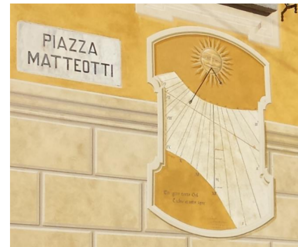
Esempio di elementi pittorici da mantenere
