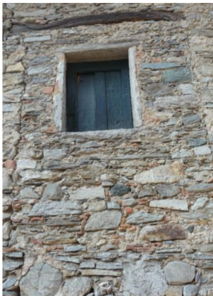
Tamponamento di originario vano di ingresso con muratura in cui sono stati utilizzati materiali eterogenei.
