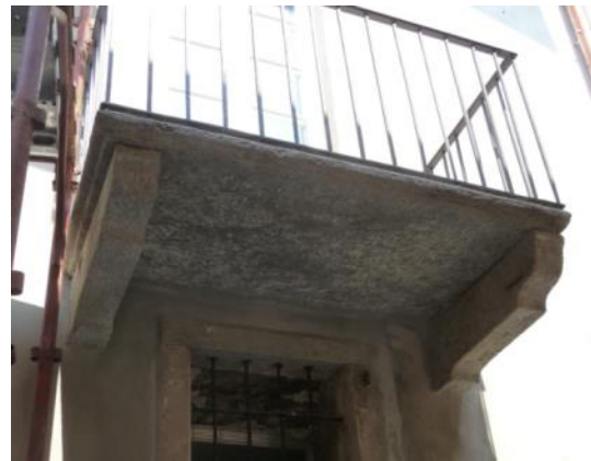
Esempio di balcone lapideo originario da mantenere
