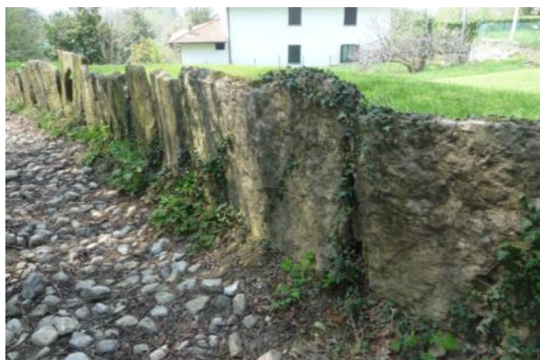
Muro a secco originario realizzato con lastroni lapidei incastrati di taglio nel terreno
