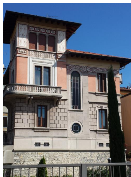
Edificio di inizio metà del '900 comunque da salvaguardare
