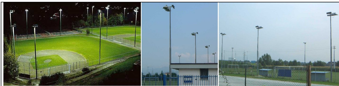
Figura 5.24 - Impianti sportivi illuminati in modo conforme alla L.R.17/00 con proiettori asimmetrici orientati orizzontalmente e che non disperdono luce verso l'alto.
